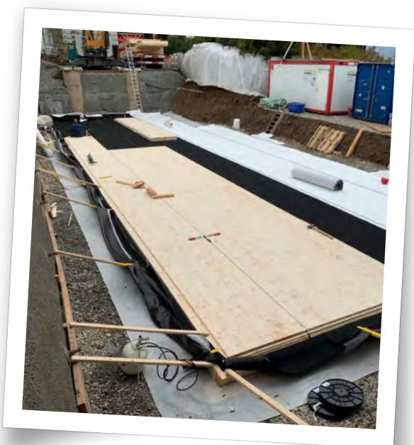
* Foto: Ausführung einer erdberührten Bodenplatte, Quelle: Timbatec Holzbauingenieure
